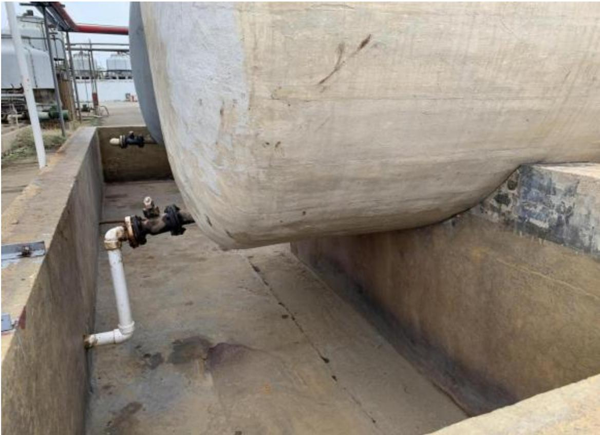
图 4.5-3 盐酸罐区（防渗措施有破损且地面有裂缝）
