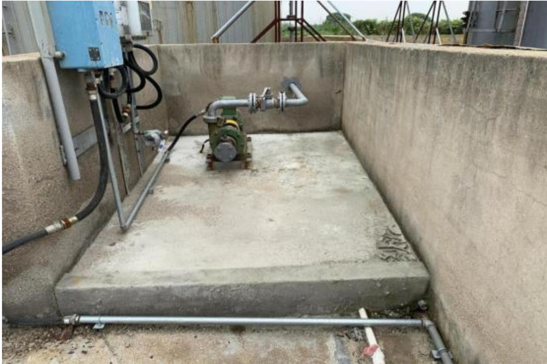
图 4.5-12 废二氯乙烷残液罐区装卸平台
