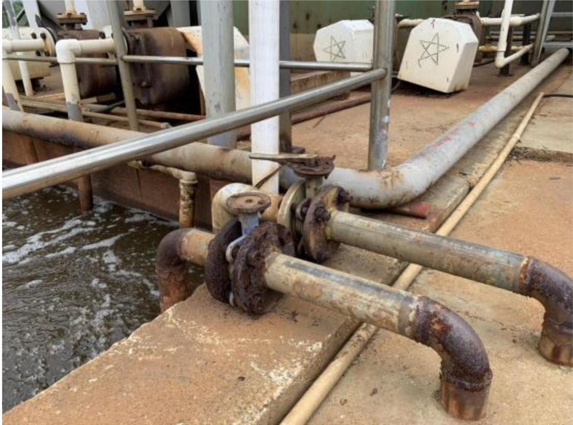
图 4.5-18 生锈管道（污水处理站）
