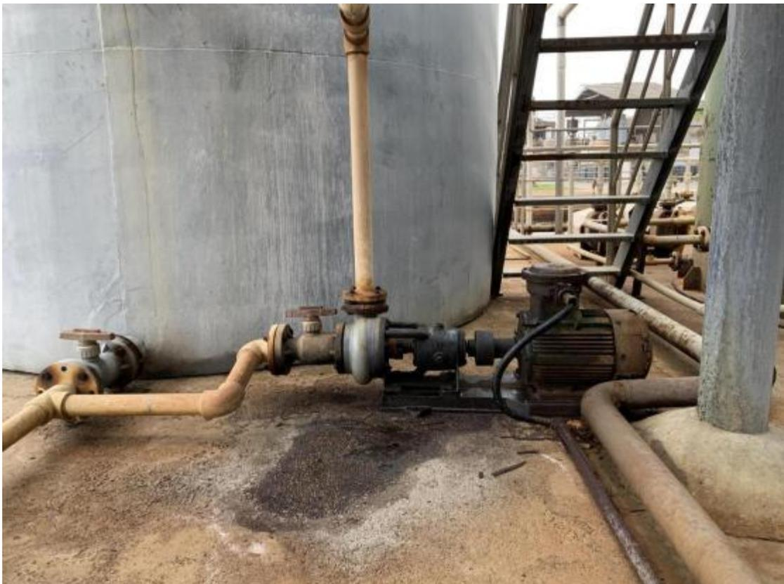
图 4.5-23 传输泵（污水处理站）
