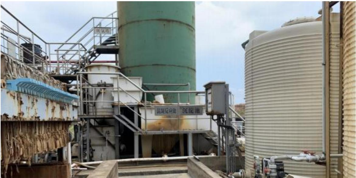
图 4.5-11 混凝反应池、沉淀池
