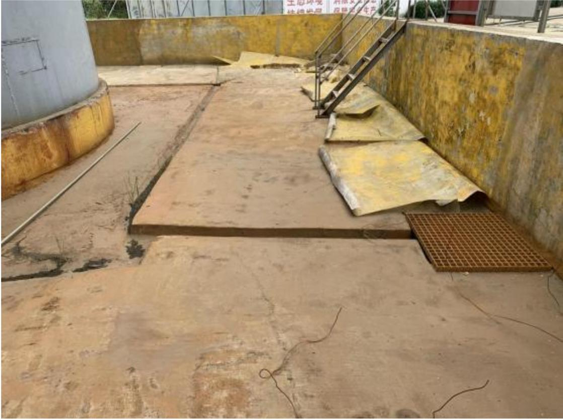
图 4.5-2 废二氯乙烷残液罐区（防渗措施有破损且地面有裂缝）
