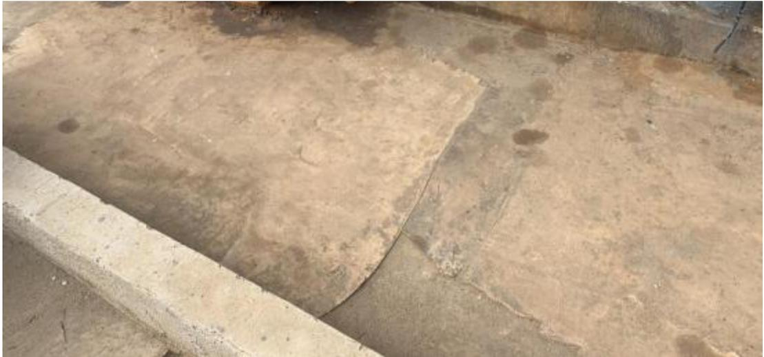
图 4.5-29 氯乙酸甲酯车间（地面防渗措施有破损）
