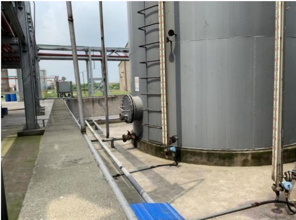
图 4.5-5 装置罐区（无防渗措施）
