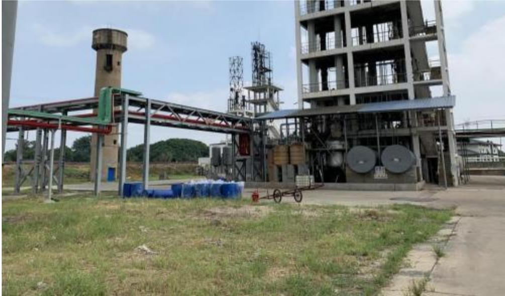
图 4.5-16 地上管道（生产废水进入污水处理站）
