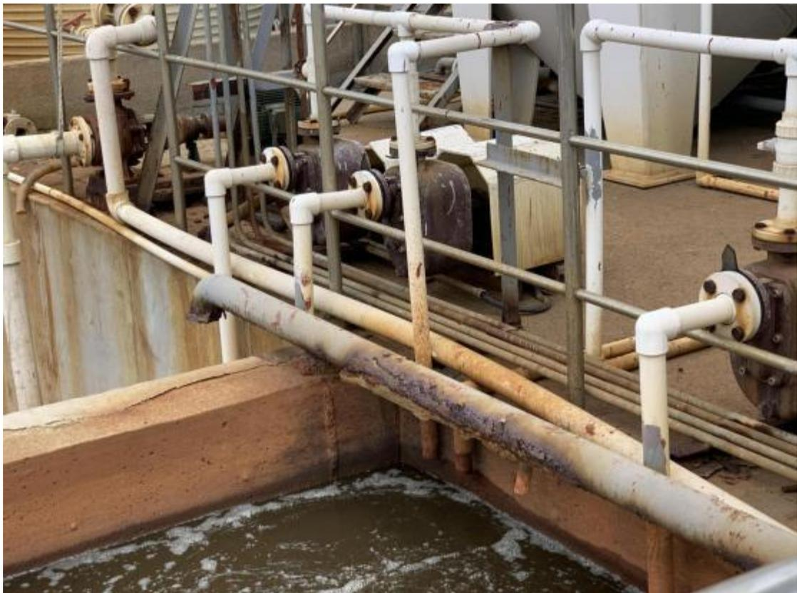
图 4.5-19 被腐蚀管道（污水处理站）
